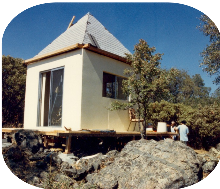
Cốc Thầy ngày được xây dựng, tháng 9 năm 1987, bđ Đào Phát đứng xoay lưng.
