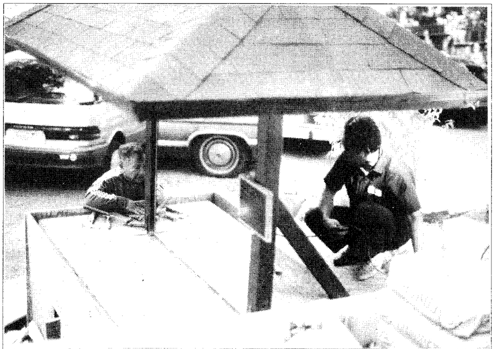
• Bạn đạo đang sửa chữa máy bơm nước trước cổng T/V Vi Kiên trong dịp giỗ Đức Ông Tư.
